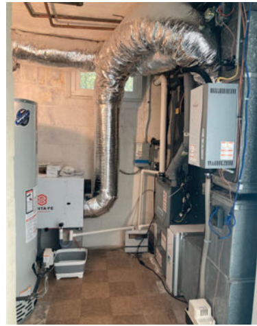
加・除湿器、UVライト、フィルター等コンパクトにまとまったボイラー室
