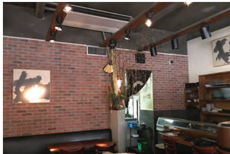
ダイキンの日本式スプリット型空調機を設置した「鹿の山」の店内
